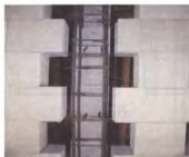
构造柱预留钢筋示例
