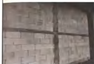
砌块填充内墙立面示例图
