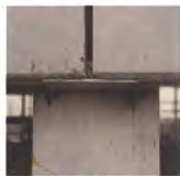
钢结构外墙横板 专用托板示例图
