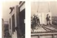
拼装大板吊装及安装示例图
